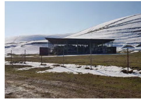
La FSD a déplacé des tonnes de terre polluées par des pesticides vers cette structure de dépôt centrale, que l'organisation a réhabilitée et protégée pour garantir un stockage sûr de ces déchets toxiques.
