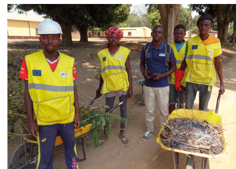
Une vingtaine d'entreprises locales ainsi que des jeunes en formation ont été associés aux travaux de réhabilitation de la FSD à Bouar.
